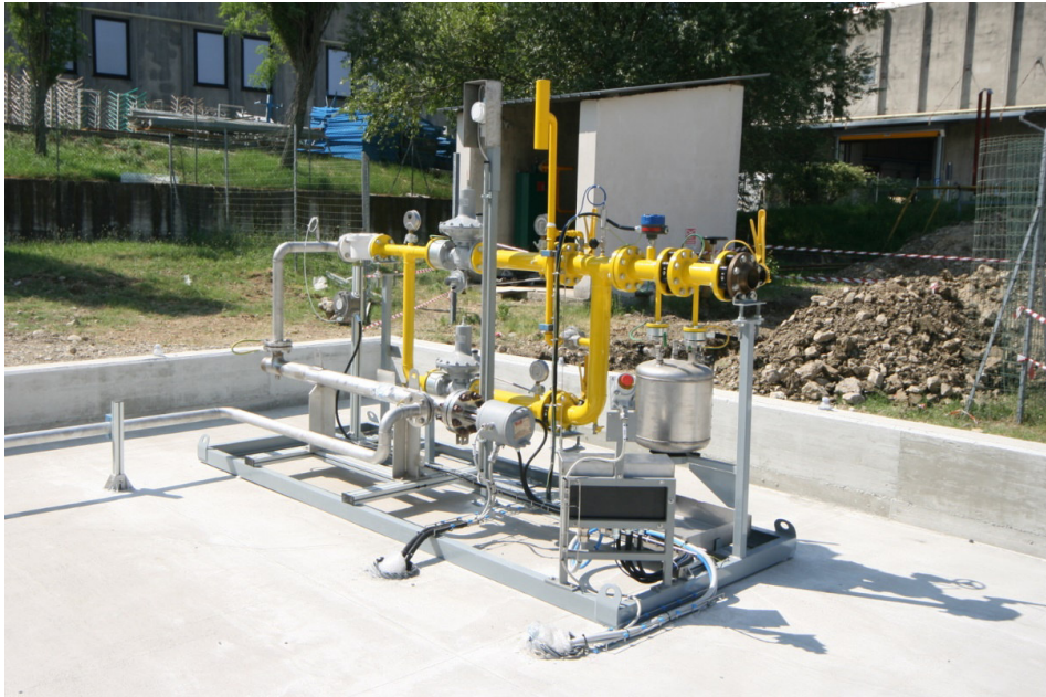
Fig. 6 Esempio di gruppo di riscaldamento
