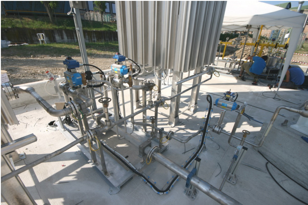
Fig. 4 Esempio di gruppo di scambio e blocco
