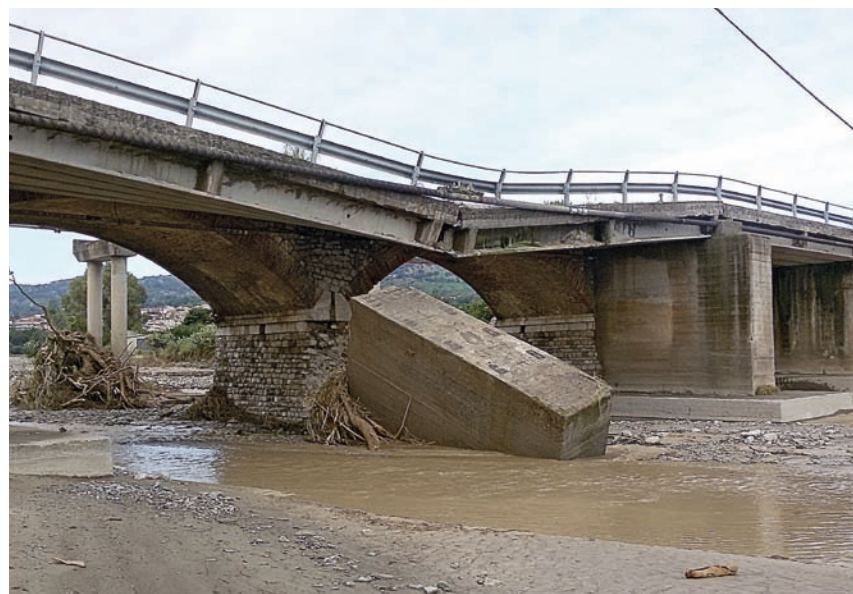
In alto, i drammatici effetti dell'esonazione delle fiamme nella zona della locride; in basso, crollo di un viadotto della SS 106 Jonica.
