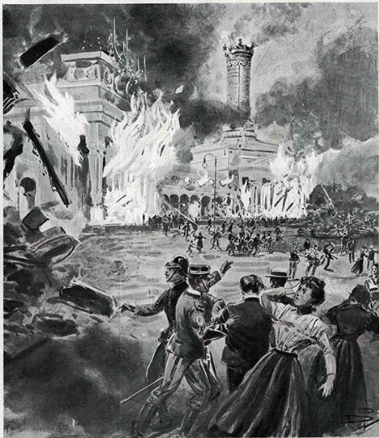
L'INCENDIO DELL'ESPOSIZIONE DI COMO. — Il fuoco invade la facciata.
