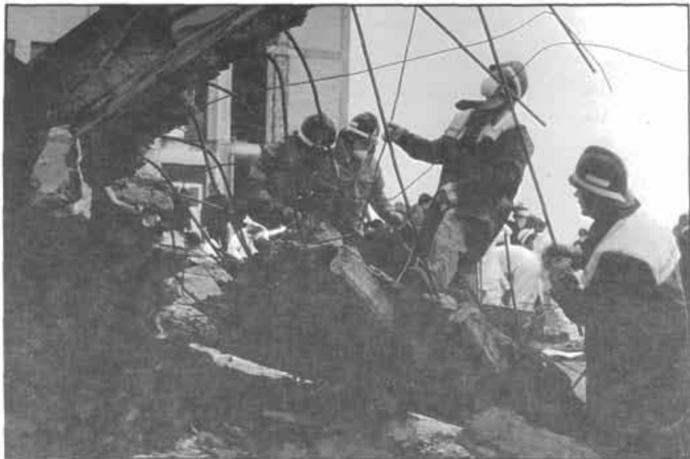
▲ Vigili al lavoro tra le macerie dell'ospedale di S. Angelo dei Lombardi
