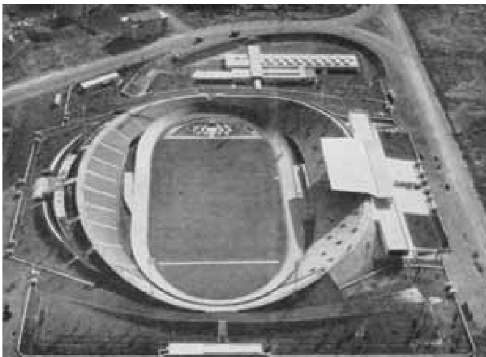
Il Velodromo Olimpico all'EUR, inaugurato il 30 aprile 1960 e demolito nel luglio 2008
