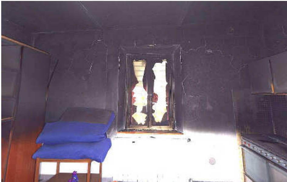
Foto NIA – Finestra con segni del deposito di fuliggine su tutta la superficie
