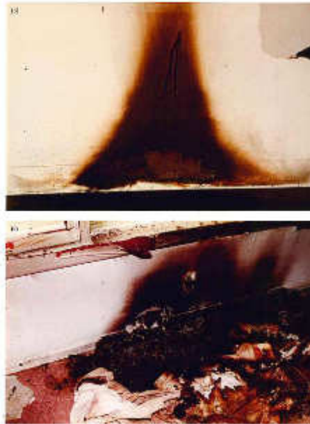
Segno a cono rovesciato: notiamo un triangolo sul muro e un segno circolare sul pavimento
