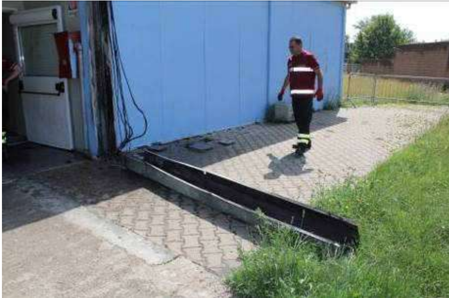
Riposizionamento della lamiera metallica
