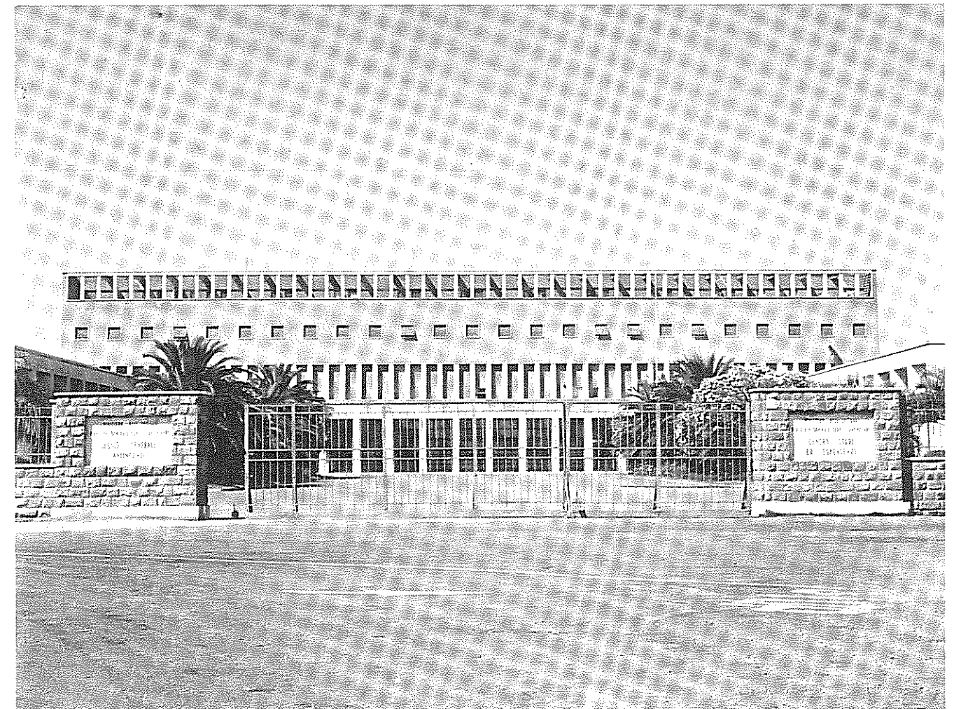
L'ingresso da Piazza Scilla è in comune con le Scuole Centrali Antincendi. Nell'edificio principale gli uffici della Direzione ed i locali del Laboratorio di Chimica sono ubicati al piano rialzato.
