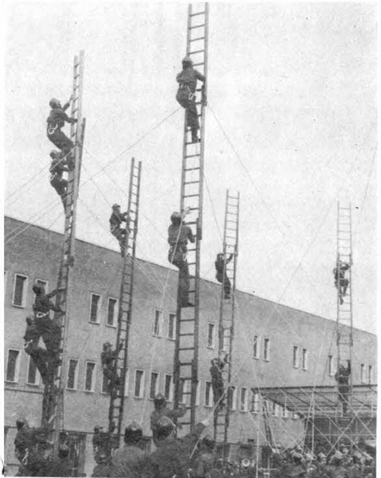
Per la sua maneggevolezza e manovrabilità, questo tipo di scala viene largamente impiegata in operazioni di spegnimento e di salvataggio ai primi piani degli edifici.
