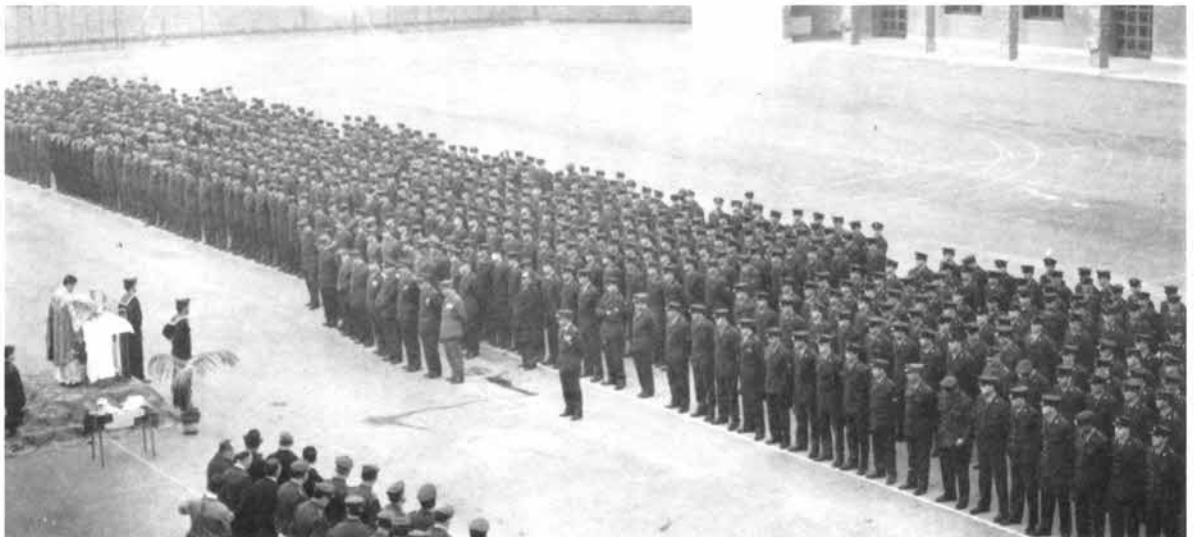
Il piazzale della Scuola Allievi.
