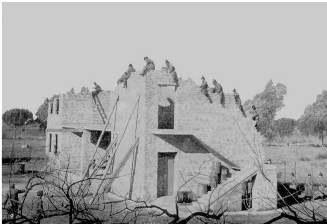
Attraversamento di muri pericolanti
