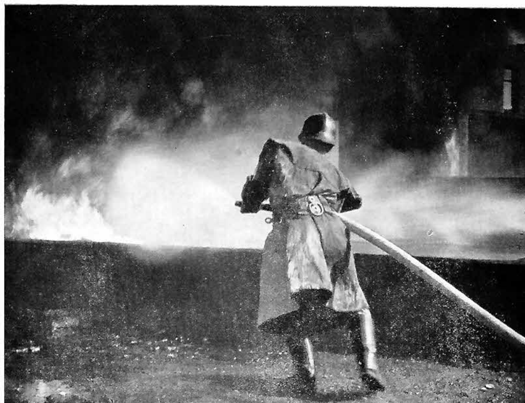
spegnimento di un incendio di liquidi infiammabili
