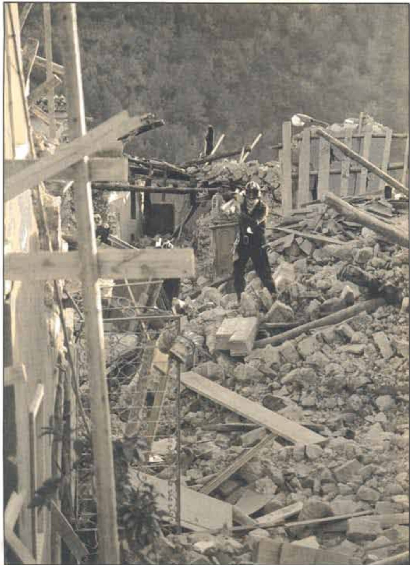
▲ Trasporto di attrezzi per la rimozione delle macerie nel comune di S. Mango sul Calore
