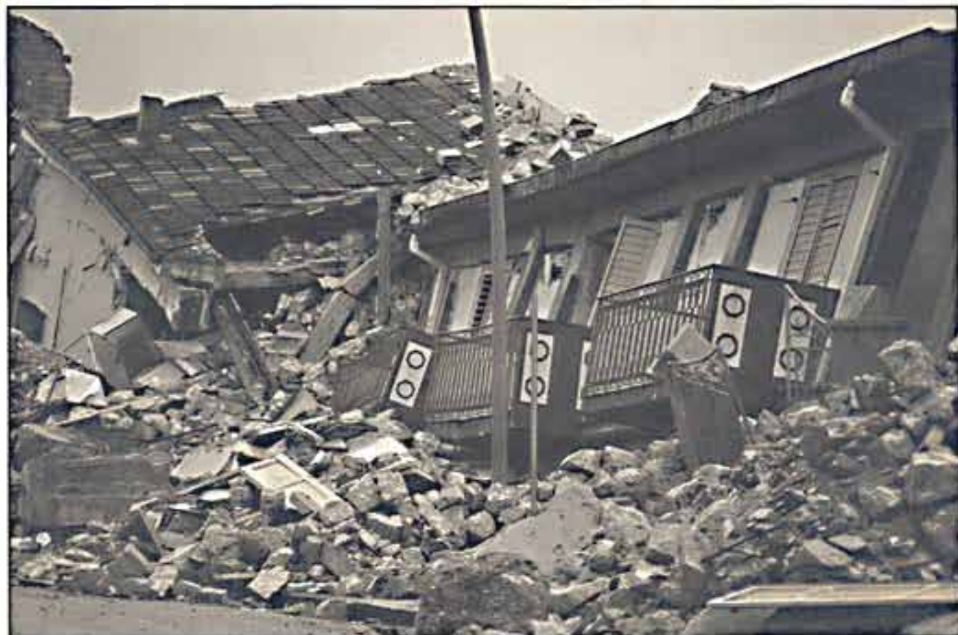
▲ Effetti del sisma su strutture edilizie nel comune di Lioni
